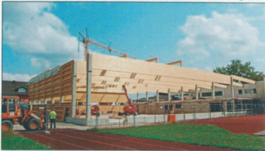
30 Meter lang und um die sechs Tonnen schwer ist jeder der die Brettschichtholzträger für die Dachkonstruktion der Comenius-Turnhalle. – Foto: Brandl
